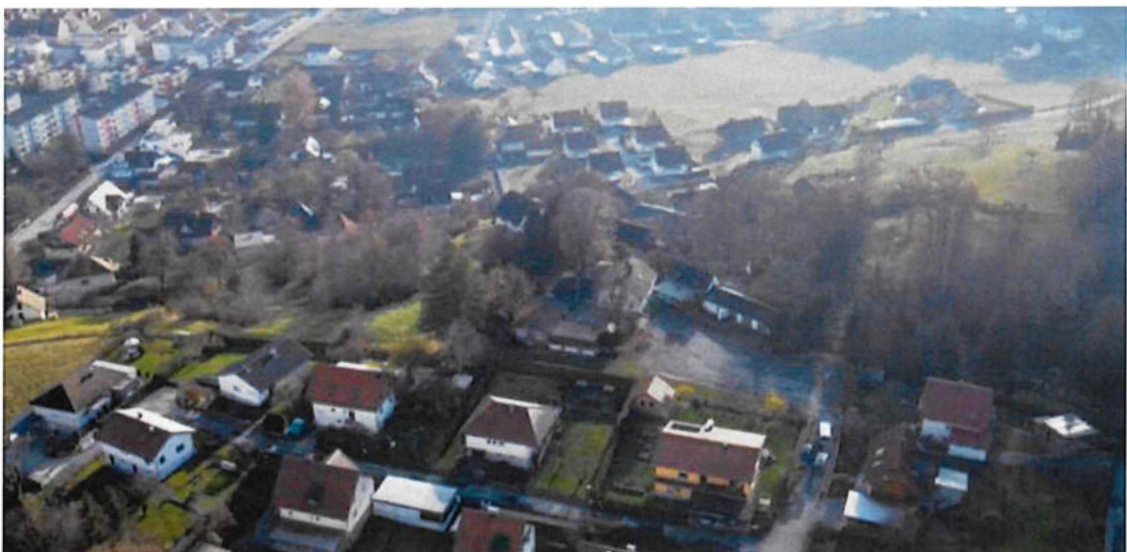
Abb. 12: Drohnenfoto – Blickrichtung Süden (Aufnahme: ANKO ZT GmbH vom 07.12.2022)
