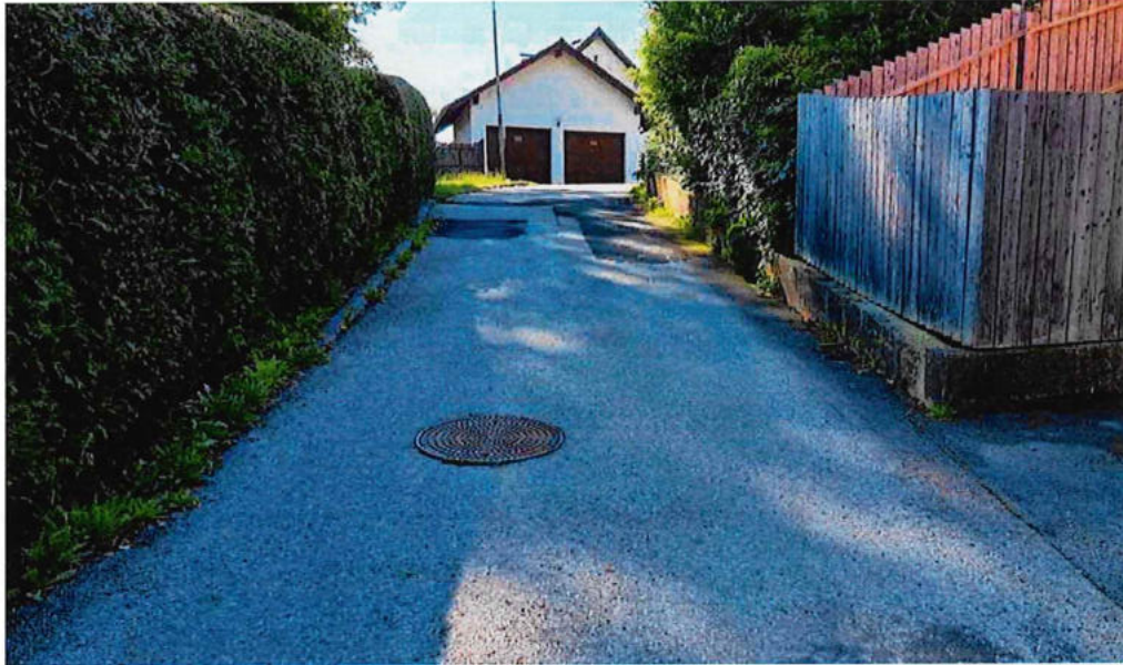
Straßenabschnitt mit einragender Hecke auf Straßengrund
