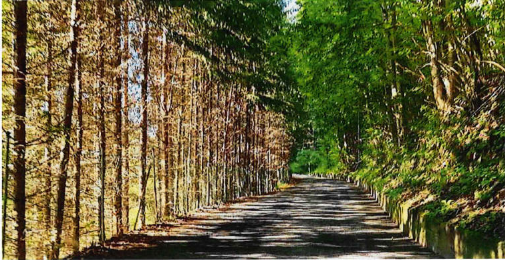
Waldabschnitt mit westseitiger Stützmauer
