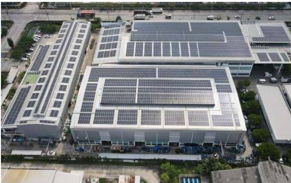
Abbildung 35: Solaranlage auf Industriegebäuden (Quelle: https://static.bangkokpost.com/media/content/20210204/c1_2062379_210204115218.jpg )
