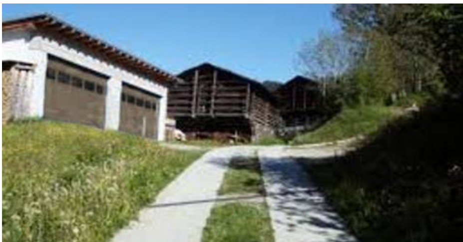
Abbildung 45: Beispiel Betonspur (Quelle: ÖBV)
