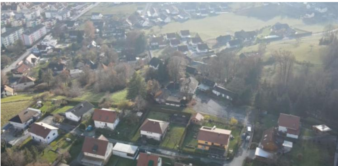
Abb. 12: Drohnfoto – Blickrichtung Süden (Aufnahme: ANKO ZT GmbH vom 07.12.2022)
