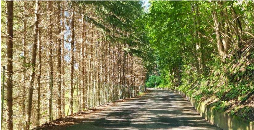
Waldabschnitt mit westseitiger Stützmauer
