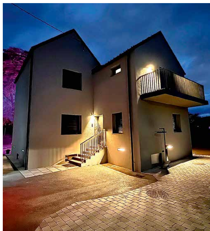
Der thermisch sanierte Lutena-Sitz in der Gratweiner Straße 65
