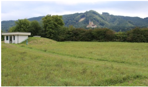
Abbildung 5 Blick Richtung Südosten
