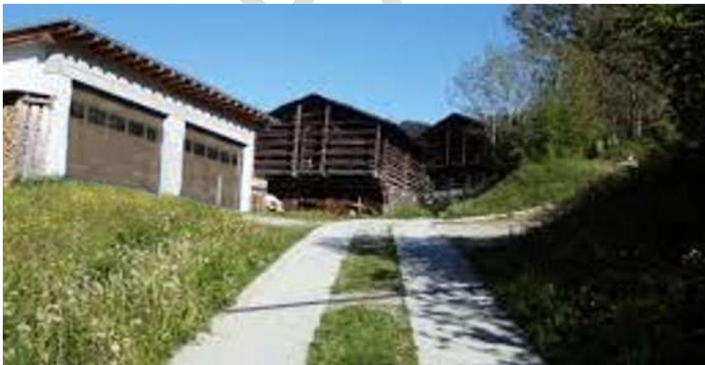
Abbildung 47: Beispiel Betonspur (Quelle: ÖBV)
